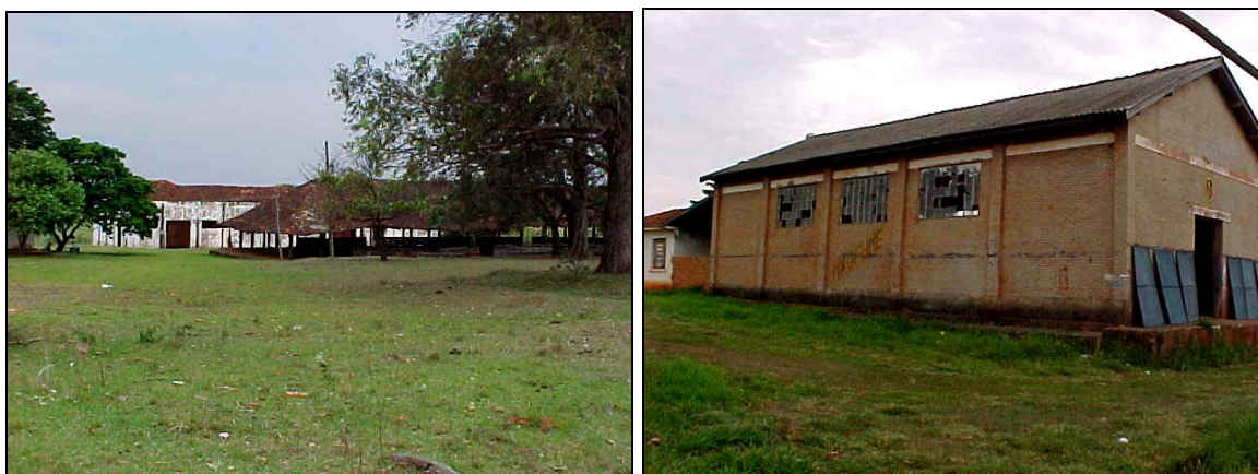
Figura 9. Barracão da Braswey (esq.) e da Sanbra (dir.) no município de Mirante do Paranapanema: dois símbolos da importante fase de produção algodoeira (1950-1965). O abandono desses estabelecimentos atesta o processo de decadência e de crise das economias locais-regionais observadas no sudoeste paulista, Passos: 15/04/2003.
