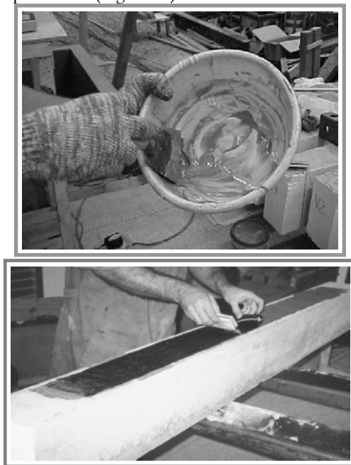
Figura 10. Mistura manual da resina epóxi e aplicação da manta de fibra de carbono
