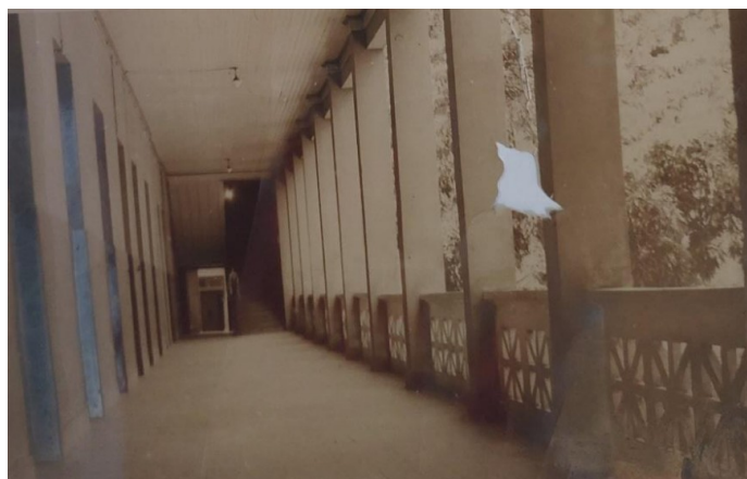
Figura 5. Corredor avarandado do segundo pavimento do Instituto.
