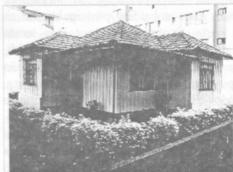
Fig. 01: Rua São Silvestre. ¶ Casa recém pintada e reformada. ¶ Encontra-se em bom estado de conservação. ¶ Fotog. V. Ferraz
