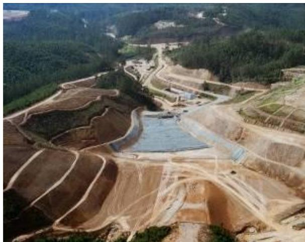
**Figura 2:** Imagem mostrando o sistema de impermeabilização no Aterro Sanitário Caieiras (CTR-Caieiras)
