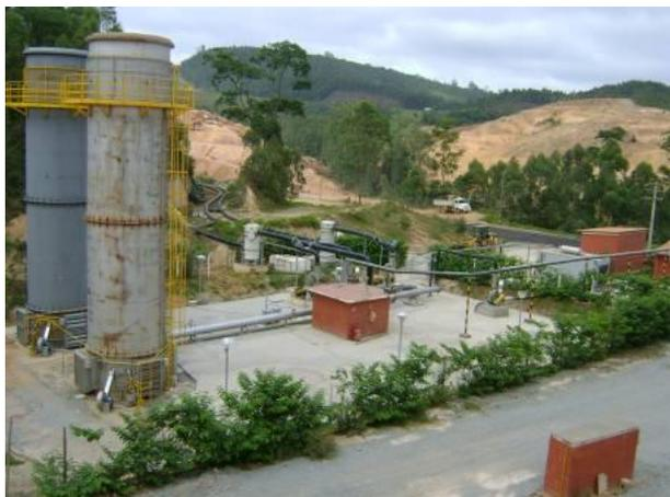
**Figura 4:** Imagem mostrando o sistema de captação de biogás/metano no Aterro Sanitário Caieiras (CTR-Caieiras)
