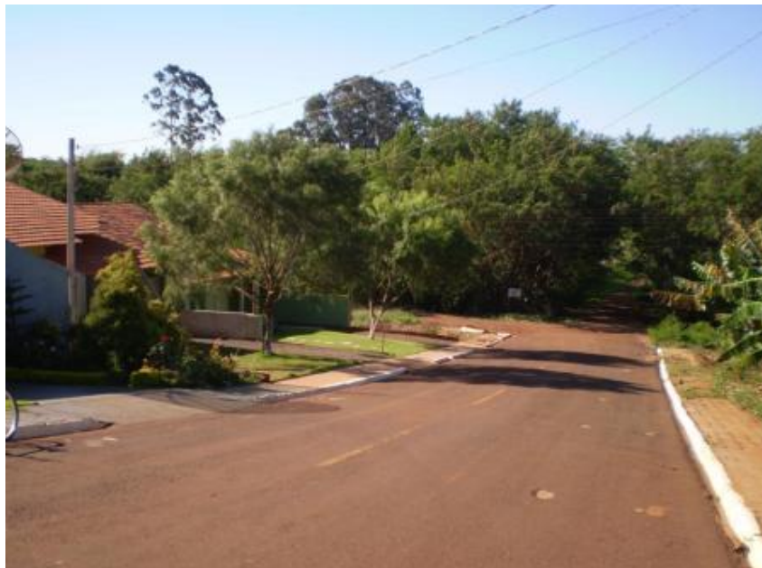
Figura 7: Detalhe das casas construídas a menos de 50 m do Córrego Guavirá.
