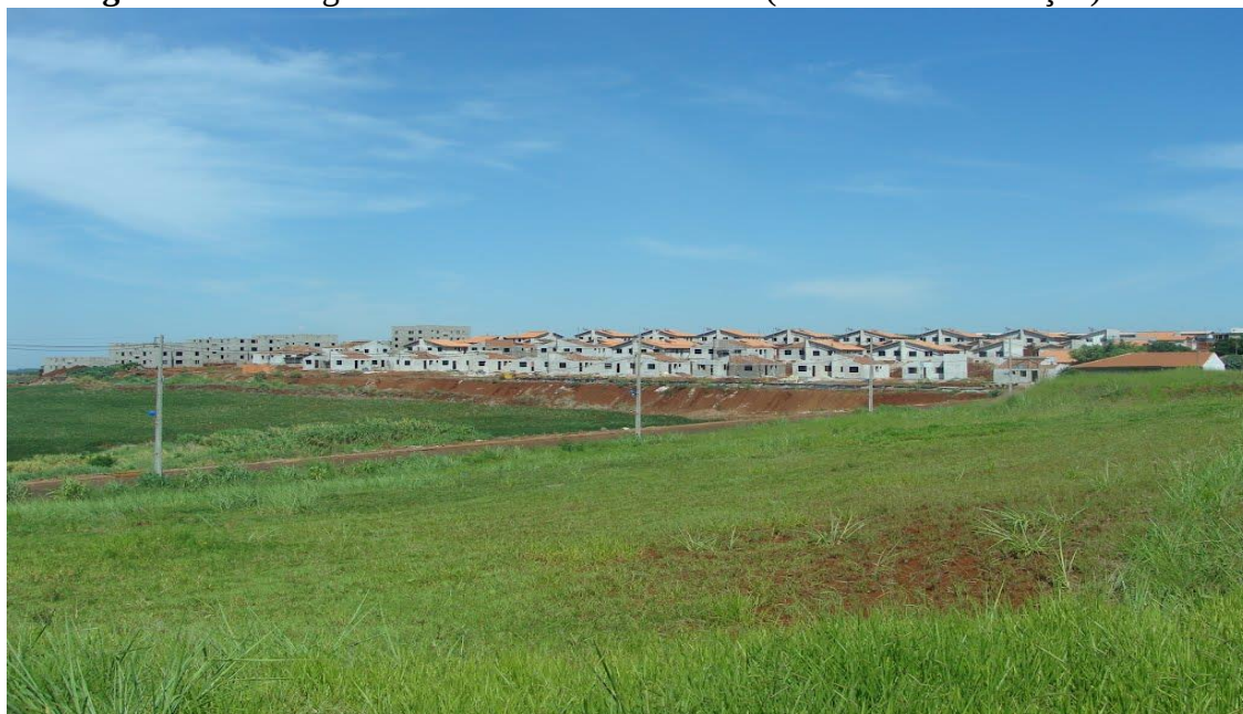
Figura 3 – Maringá. Residencial Dolores Duran (em fase de construção). 2011
