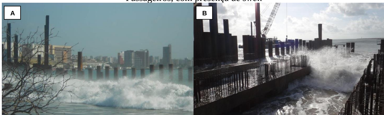
Figura 7: (A) Obra paralisada pela ressaca do mar (B) Ressaca no local das obras do Terminal de Passageiros, com presença de swell
