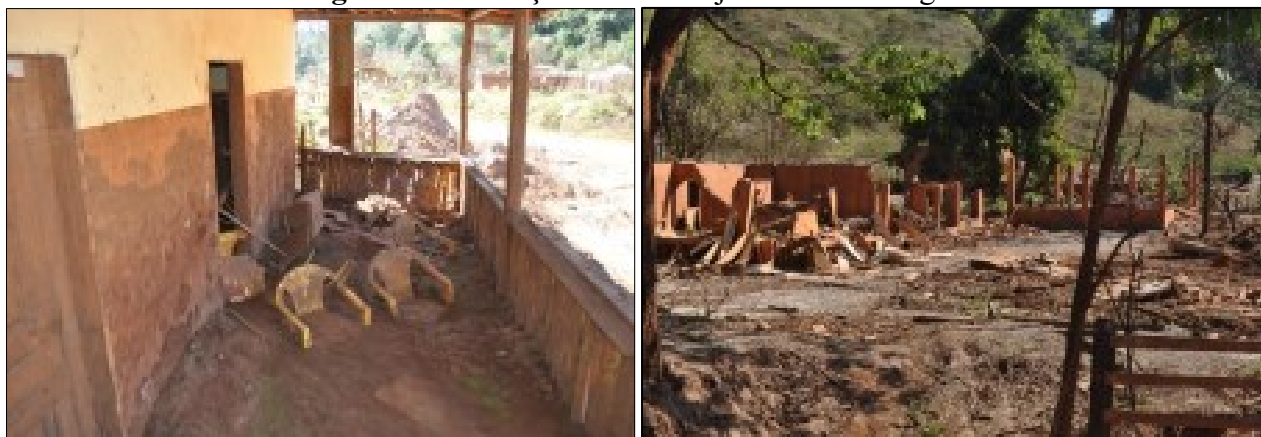
Figura 6: Destruição de casas a jusante da barragem
