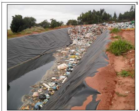
Figura 9a – Vala com manta, separando o chorume do solo
