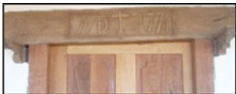
Figura 12 - Posta de Pozo del Tigre.
