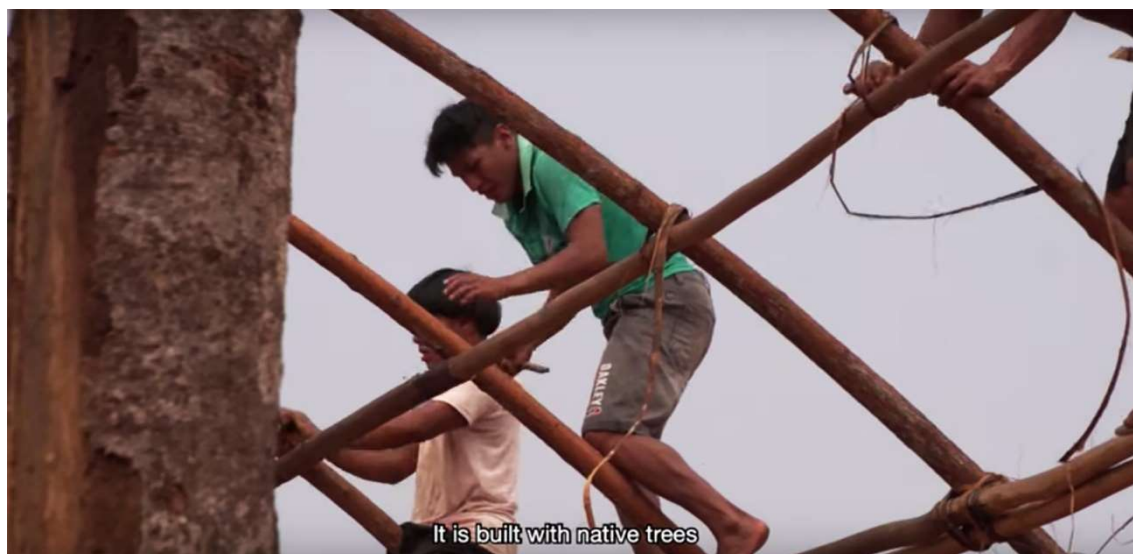
Construção da maloca.
