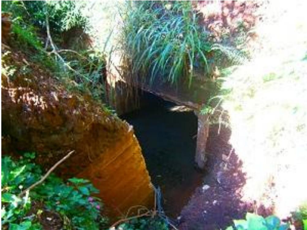
**Figura 10: Imagem evidenciando o rompimento da galeria de águas pluviais localizado no interior da área de estudo na cidade de Campo Mourão (PR)**
