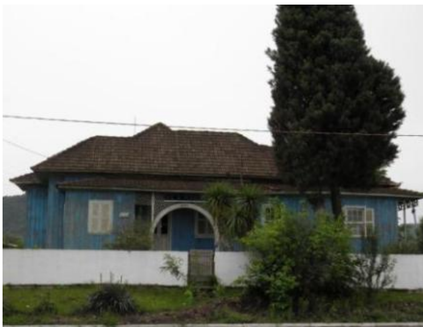
Figura 6: Vista frontal da Casa Amazonas, em União da Vitória (PR) Fonte: Autores, em 05 de Julho de 2013
