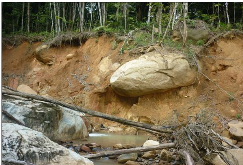
Figura 12: Fotografia demonstrando depósito de colúvio, evidenciando movimentos pretéritos. Rochas com elevado grau de intemperismo inclusive com esfoliação esferoidal.
