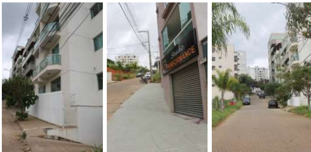
Figura 11: Problemas antigos reproduzidos em novo loteamento
