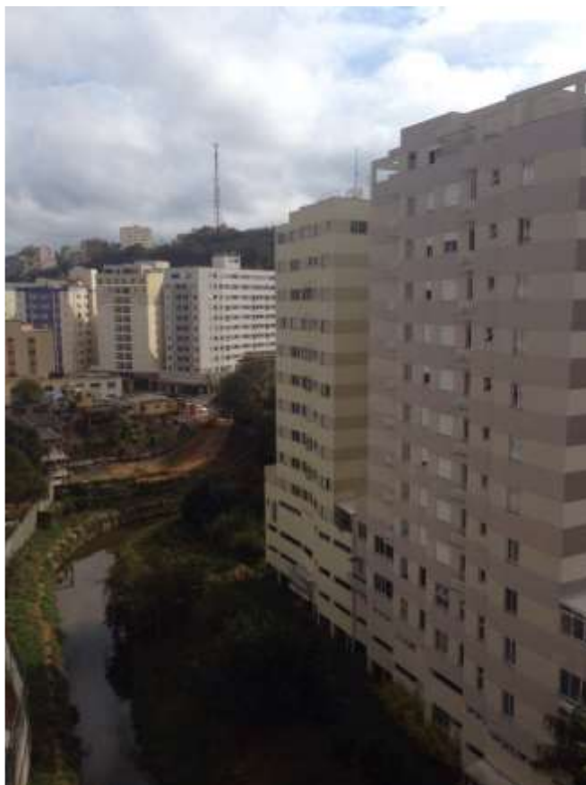
Figura 08: Novas construções não respeitam o ribeirão da cidade, muitas vezes com o aval do poder público
