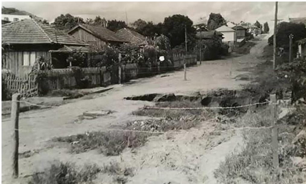
Figura 03: Boçoroca da Água da Lavadeira no bairro Vila Yolanda, Rancharia-SP
