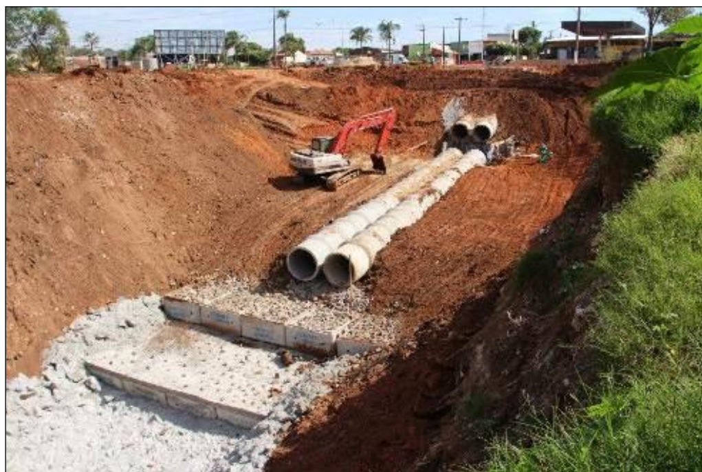
Figura 09: Degraus de recepção das águas pluviais. Foto: [autor] Data: 16/08/2015.
