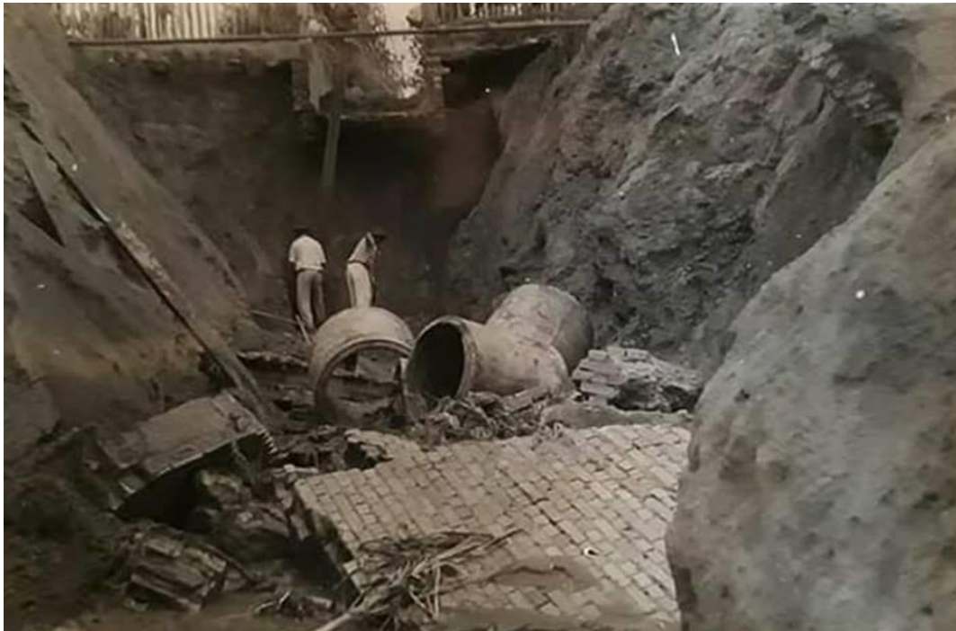
Figura 04: Erosão remontante com destruição de drenagem urbana em Rancharia-SP
