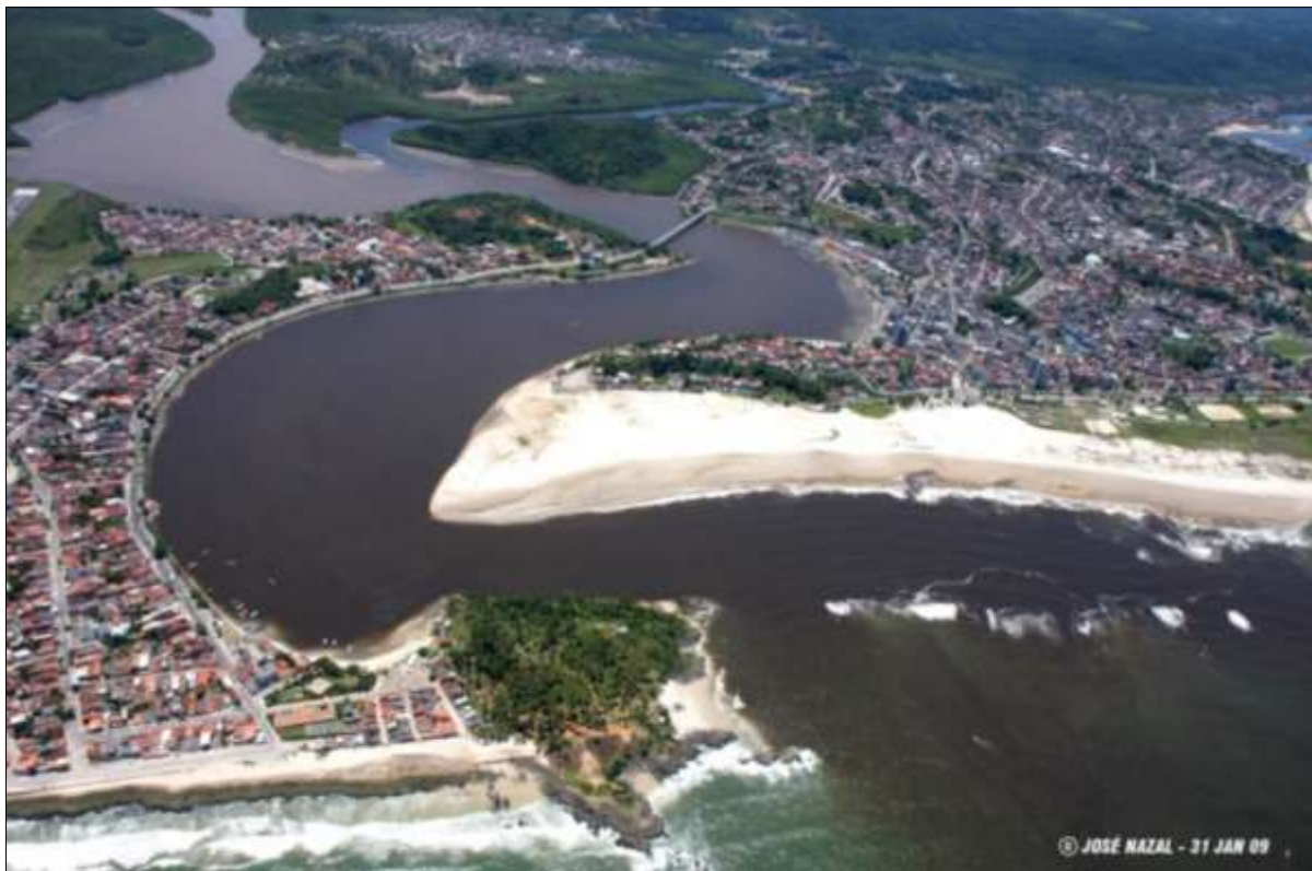
Figura 3 – Paisagem da Baía do Pontal – Avenida Lomanto Júnior e Praia do Cristo, antes da construção da ponte Ilhéus-Pontal
