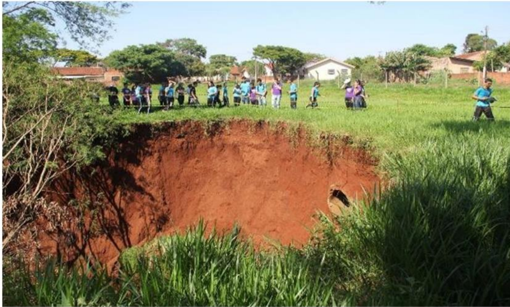
Figura 04 – Campo Mourão, Parque Gralha Azul: processo erosivo, 2015 Fonte: Dieniffer Fernanda, Julho de 2015
