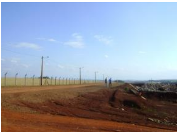
Figura 2. Vista parcial do cercamento do aterro
