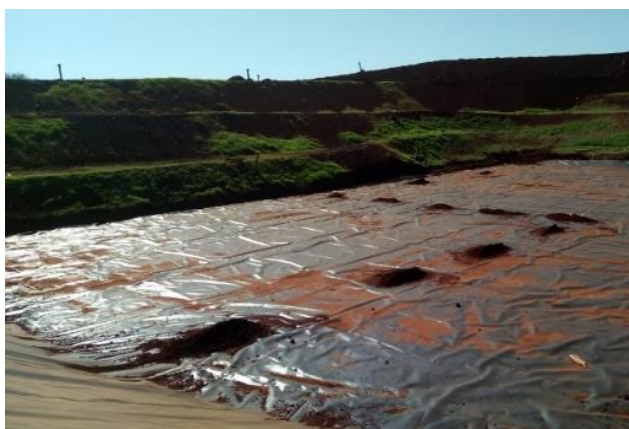
Figura 4. Execução da nova célula no aterro sanitário de Sarandi-PR
