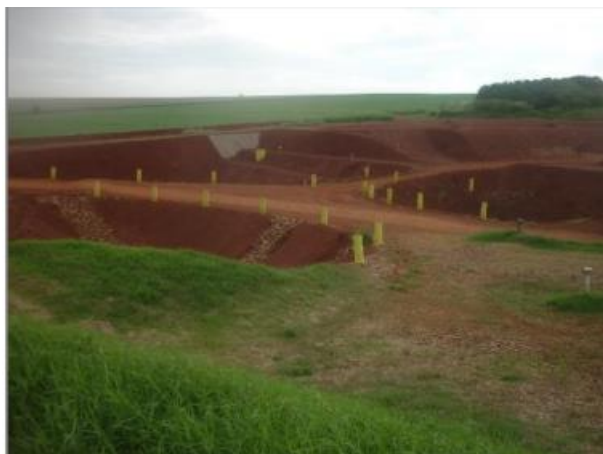
Figura 7. Conceção geométrica do aterro sanitário de Sarandi/PR
