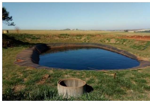
Figura 5. Lagoa para armazenamento do lixiviado
