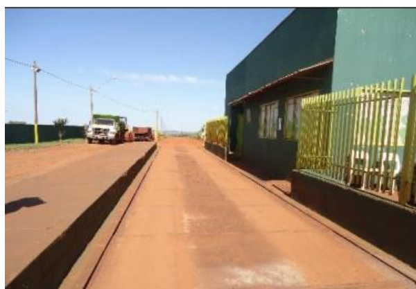
Figura 3. Balança e guarita para controle no recebimento de resíduos
