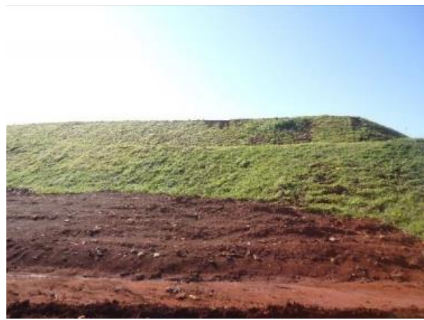
Figura 8. Constituição de patamares no aterro sanitário de Sarandi/PR
