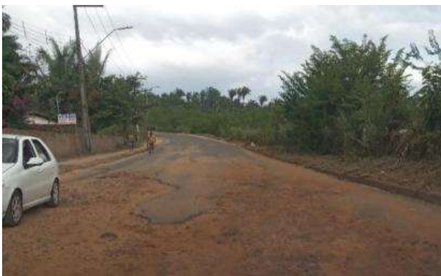
Foto 03: Via de acesso ao Res. Turiúba.
