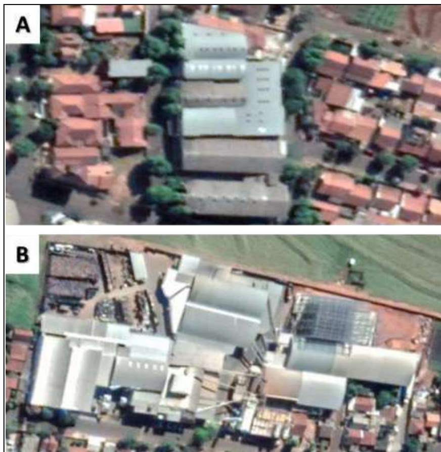
Figura 10. Grandes edificações no Jardim Beija-Flor (A) e Jardim Industrial “Novo Horizonte” (B) da cidade de Japurá/PR.
