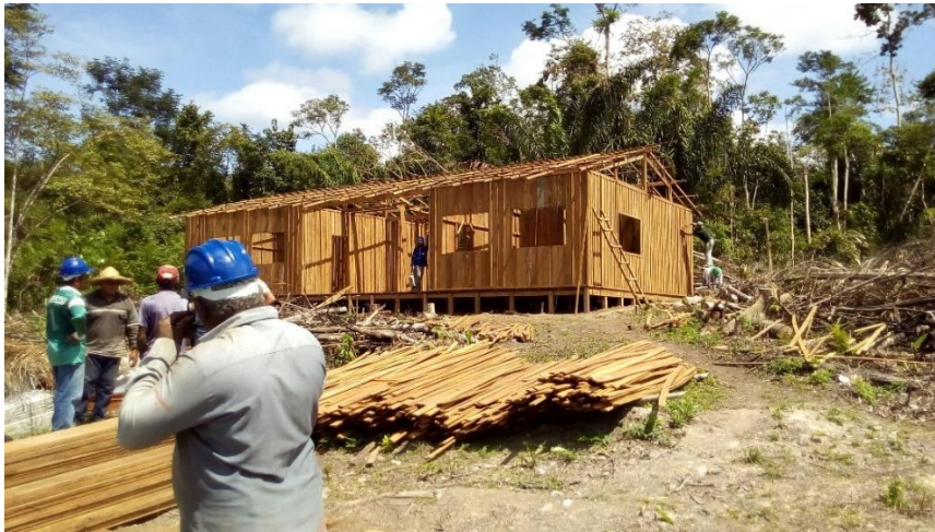
Figura 4 - Construção da escola na localidade Palhal, Altamira (PA)
