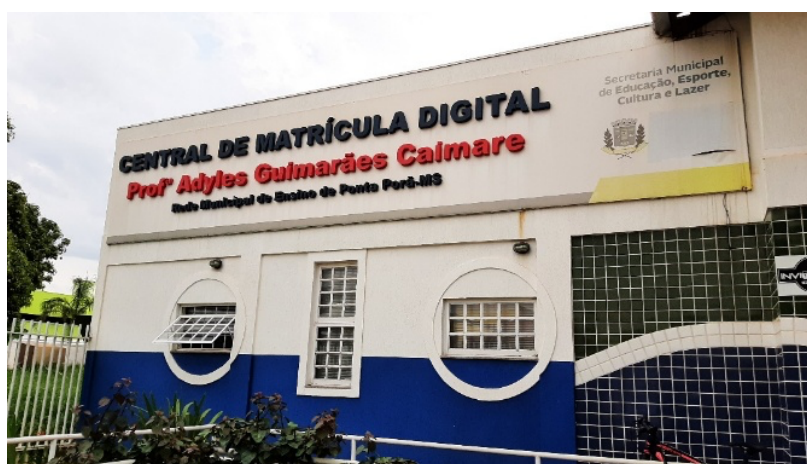
Figura 2: Fachada da Central de Matrícula Digital de Ponta Porã – MS
