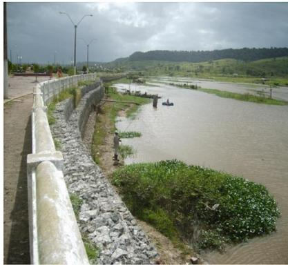
**Figura 5. Aspecto do muro de arrimo para contenção das águas do rio, no Parque Multieventos Prefeito Nivaldo Jatobá. Fonte: Pesquisa de campo (2007).**
