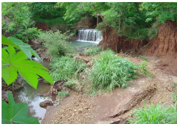
Figura 17 – Curso a jusante da passagem, mostrando degrau criado pela área concretizada da passagem, criando uma paisagem completamente diferente do setor a montante.
