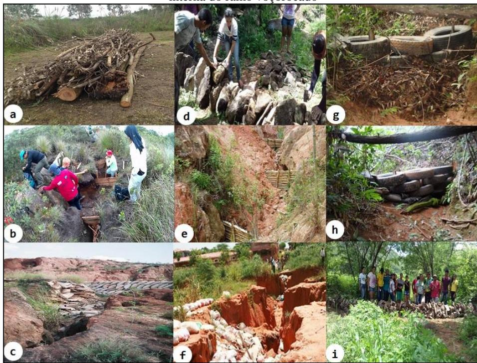
**a)** Paliçada com arvores e galharias, **b)** barreira com madeiras descartadas, **c)** barreira com sacos de solos pedregosos, **d)** barreira de rochas, **e)** paliçada de bambus, **f)** barreira com sacos de pedregulhos e cascalhos, **g / h)** barreira com pneus velhos e **i)** barreira com rochas.
