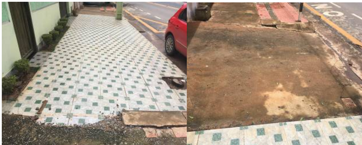
Figura 6: Piso Original da Calçada Substituído por Piso Cerâmico/Cerâmico localizado no Bairro Residencial Sul-Ipê em Montes Claros_MG, em 2020 Fonte: Morais (2020)
