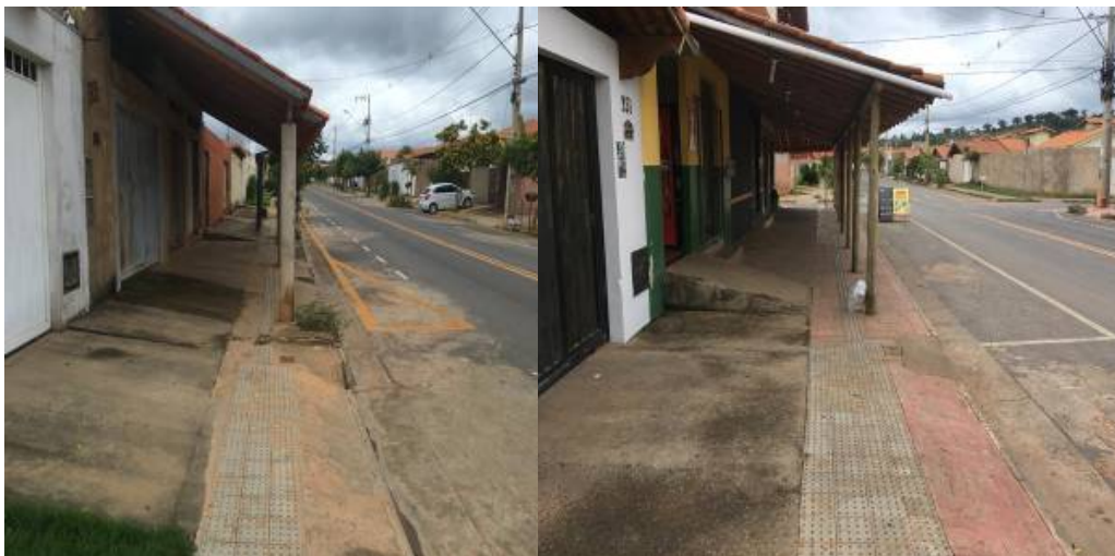
Figura 08 – Telhado sobre a calçada no Bairro Residencial Sul- Ipê em Montes Claros_MG, em 2020
