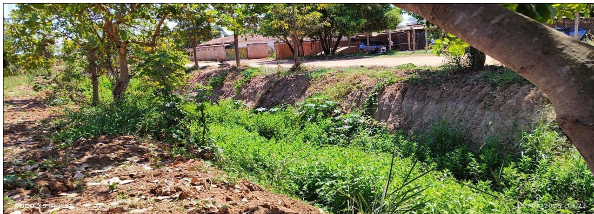
Figura 4: Córrego Lava pés - presença de plantas aquáticas que dificultam o escoamento.
