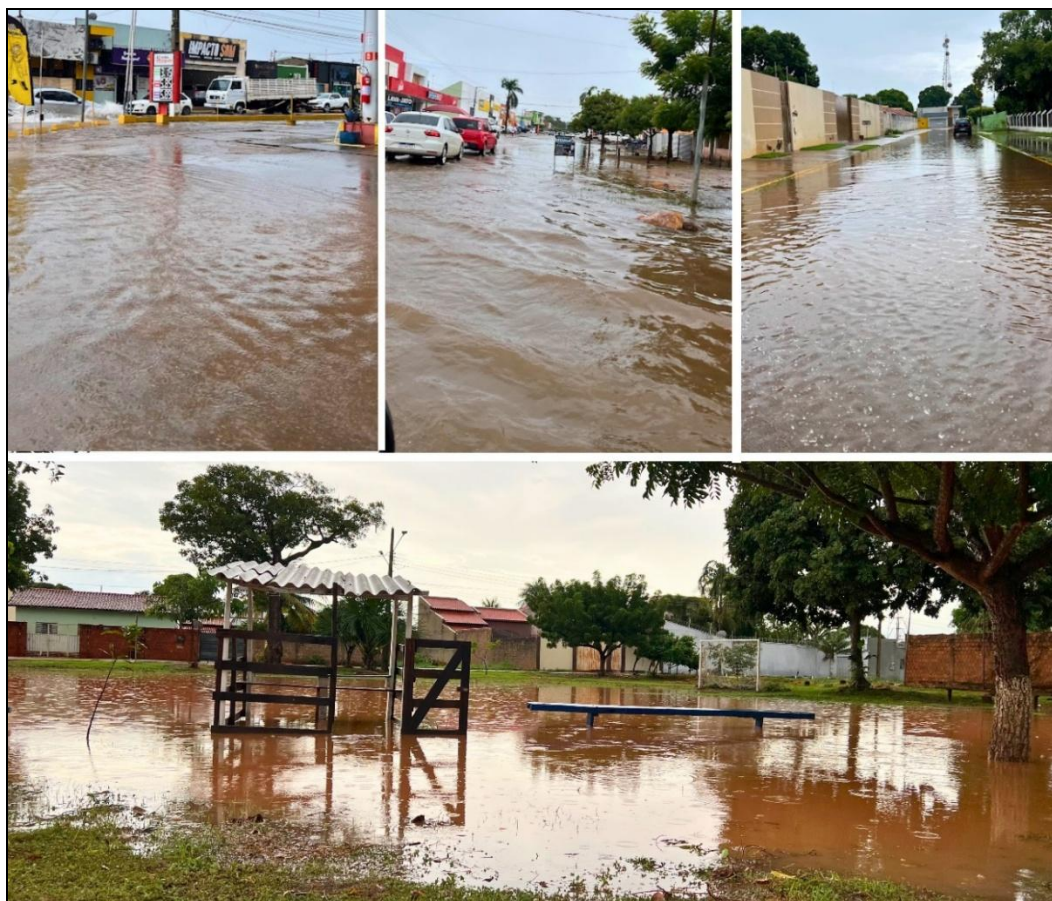
Figura 7: Registros de alagamentos em áreas urbanas de Cáceres (MT) após eventos de precipitação em 2025. Fonte: Autores, (2025).
