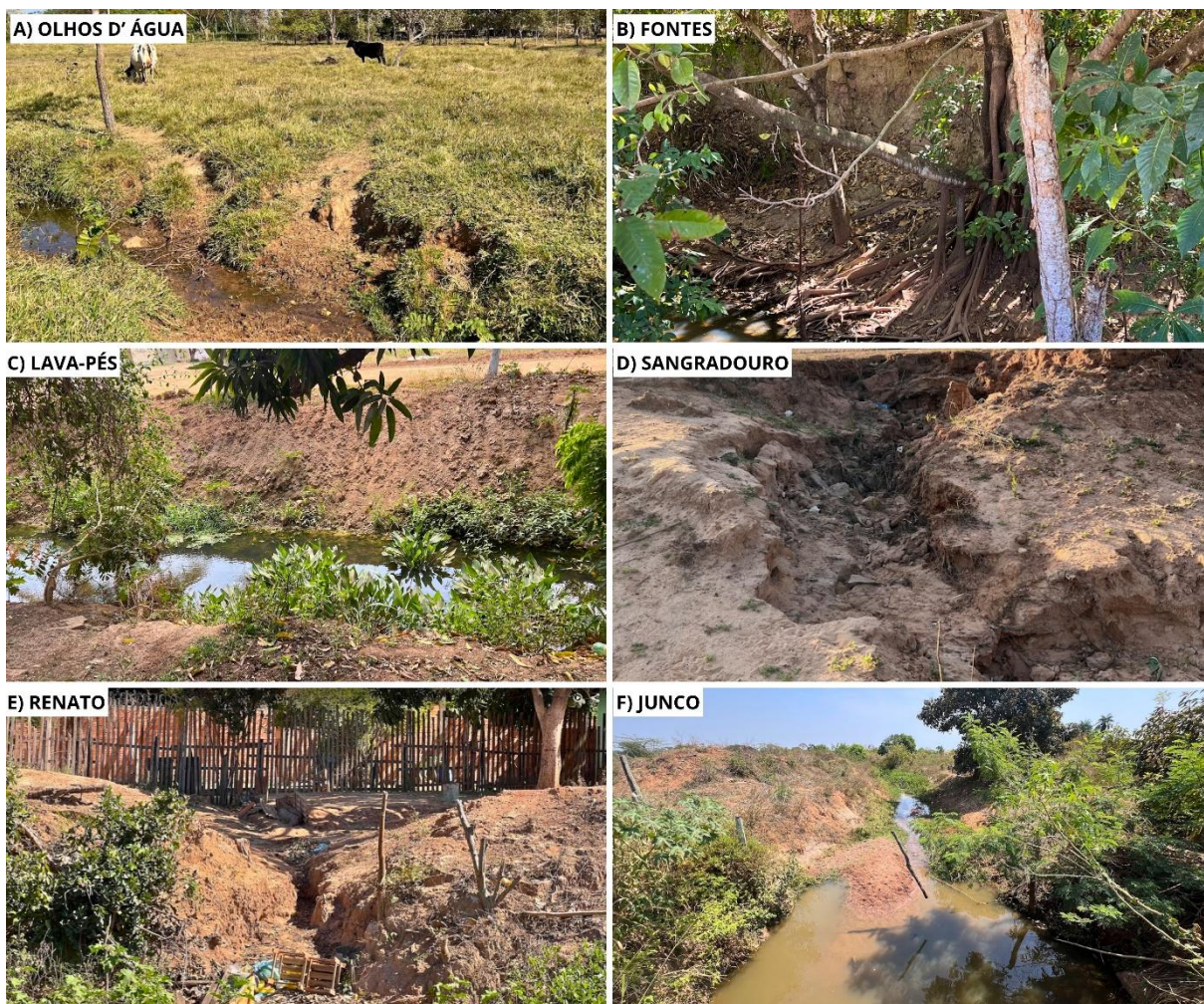
Figura 4: Processos erosivos nas bacias hidrográficas urbanas de Cáceres, Mato Grosso. Fonte: Autores, (2025).
