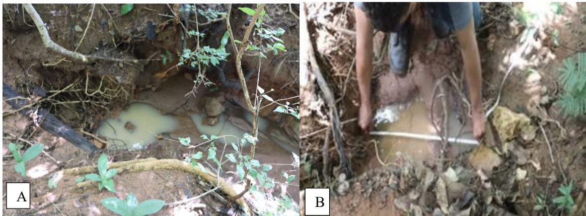
Figura 10. Característica do fluxo da nascente 4, 03/2025 Fonte: Acervo dos autores (2026).
