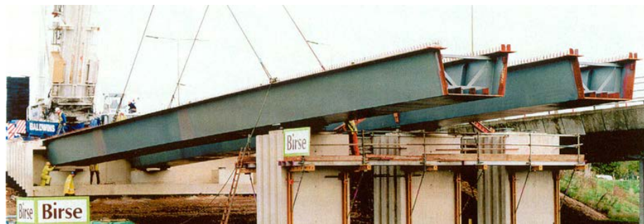
Figura 3. Vigas caixões metálicas de ponte construída na configuração em múltiplos caixões Fonte: Civil Digital 2
