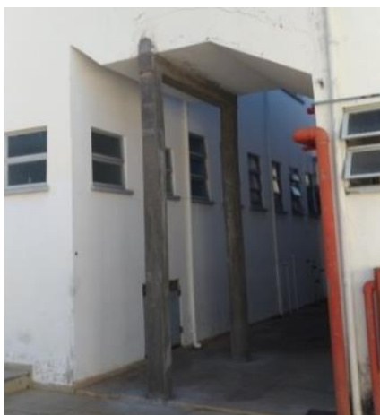
Figura 1. Reforço estrutural sob a escada do prédio da biblioteca
