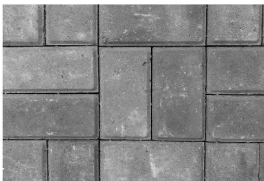
Figura 2. Modelo da calçada utilizada
