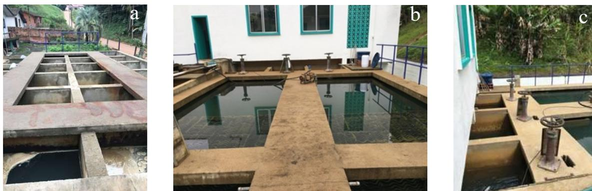
**Figura 4.** Fotos das unidades de floculação (a), decantação (b) e filtração (c).
