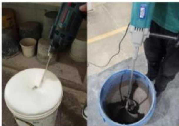
Figura 2. Mistura mecânica da espuma e da argamassa.
