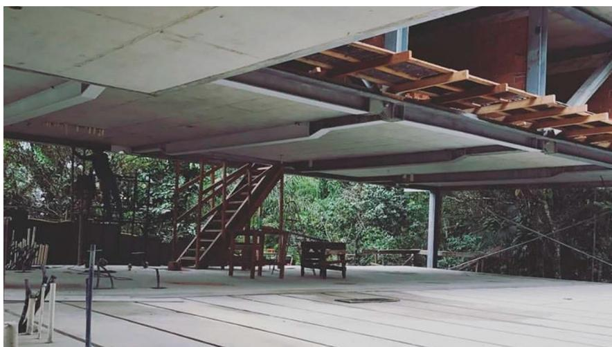
**Figura 1.** Estrutura mista para residência com vão livre de 20 metros, Terrabase (2019).
