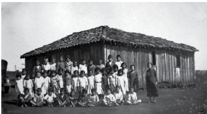
Figura 14: Escola do Bairro das Pedras – Faxina.
