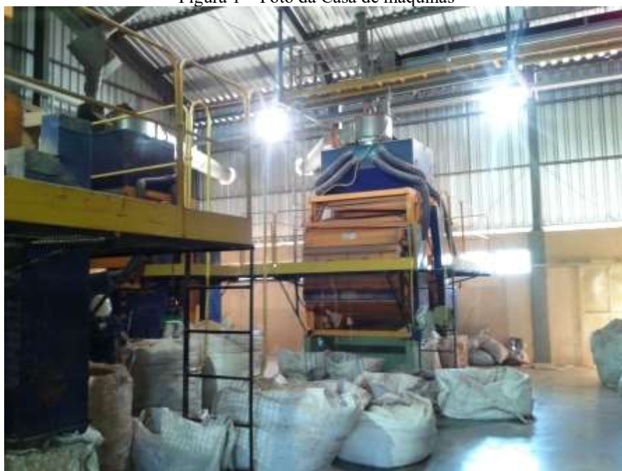
Figura 1 – Foto da Casa de máquinas
