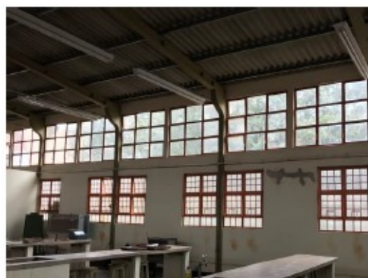
Figura 1 - Estrutura da cobertura e paredes internas
